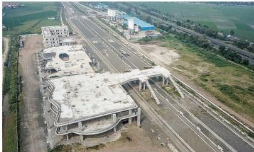
Target Operasional Kereta Cepat Jakarta - Bandung
